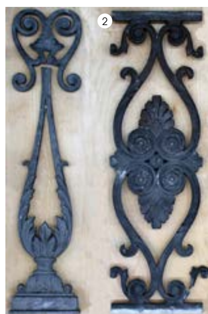
Rimozione elementi originali Removal of original elements
