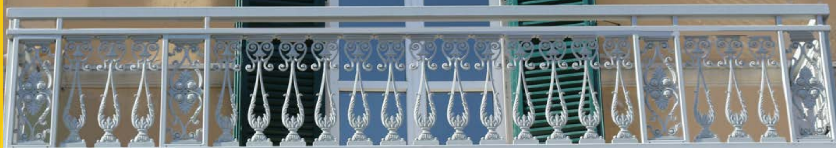
Struttura originale Original structure
